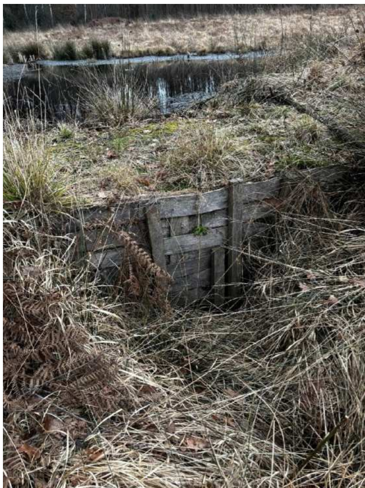
Abbildung 3-3: Beispiel einer durchgeführten Maßnahme Typ (S2): Damm reparieren im Oberen Rothenbachmoor
