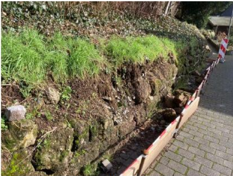
Mauer im niedrigen Bereich
