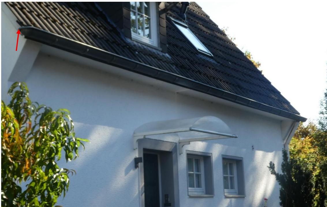
Abbildung 12: Blick von der Straße „Am Tannenhof“ auf ein Wohnhaus im nordöstlichen Geltungsbereich. Das Haus besitzt im Dachübergangsbereich Vorstände, die potentiell für Mehlschwalbennester geeignet sind. Im gesamten Geltungsbereich konnten jedoch keine Hinweise auf zurückliegende oder aktuelle Vorkommen der Art festgestellt werden. Zudem sind auch hier, wie in weiteren Wohngebäuden, Spalten und Risse im Dachübergangsbereich vorhanden, die potentiell von Fledermäusen als Quartiere genutzt werden können (roter Pfeil).
