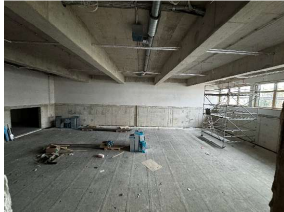
Montage der Lüftung kleine Halle
