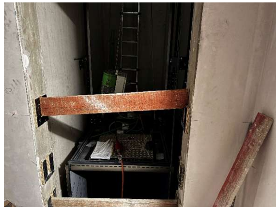
Bau des Aufzuges
