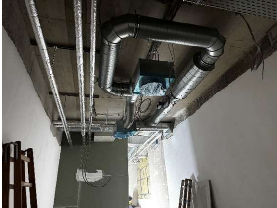
Montage der Technik Flure
