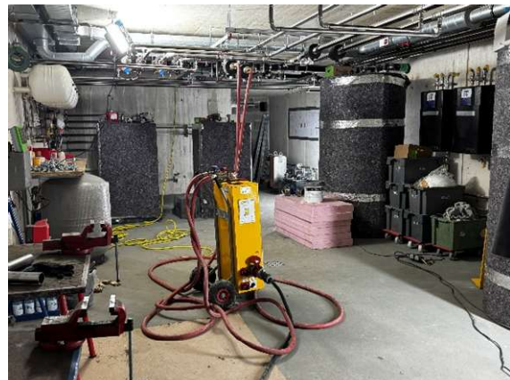
Bau der Heizungszentrale mit Wärmepumpen
