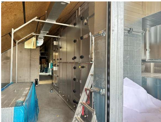
Bau der Lüftungszentrale
