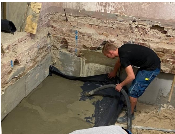
Abbildung 24: Bauarbeiten Aufzug - VHS-Gebäude Quelle: Stadt Siegburg
