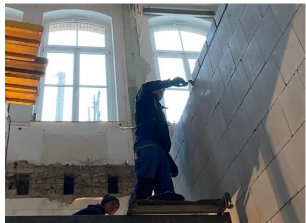
Abbildung 25: Bauarbeiten Aufzug - VHS-Gebäude Quelle: Stadt Siegburg
