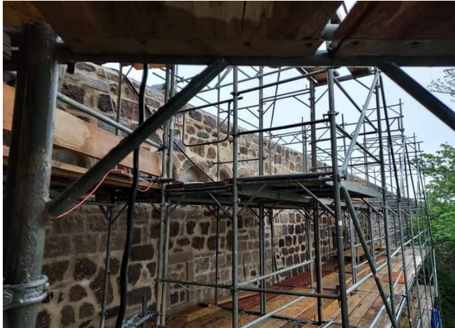
Abbildung 19: Mauersanierung Quelle: Stadt Siegburg
