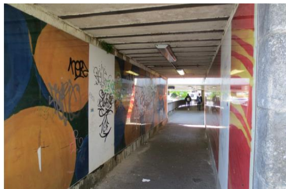
Abbildung 6: Unterführung Mahrstraße Quelle: Stadt Siegburg
