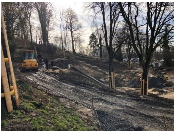
Abbildung 17: Bau der Hangsicherung Quelle: Atelier Esser
