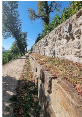
Abbildung 20: Sanierte Mauer Quelle: DSK
