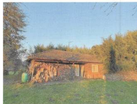
HAUS BESTAND WIRD ABGEBROCHEN
