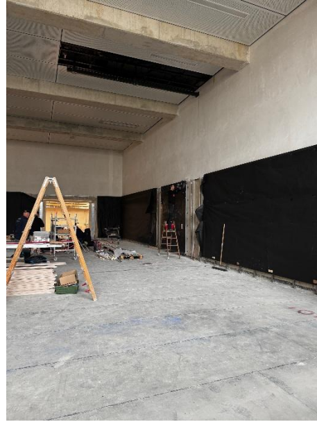
Bau der Prallwände Einfachhalle
