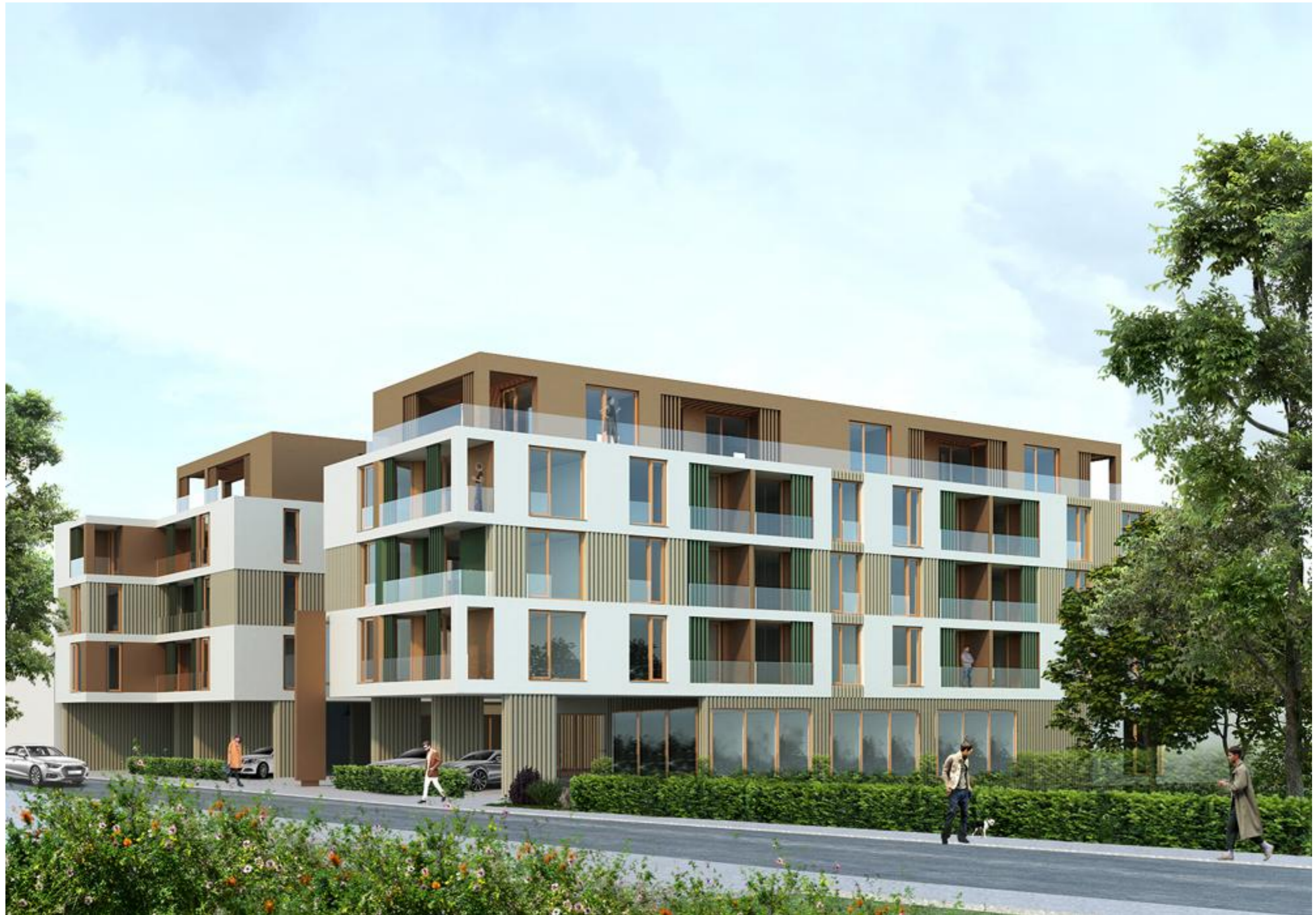
Errichtung einer Wohnanlage mit Gewerbefläche
