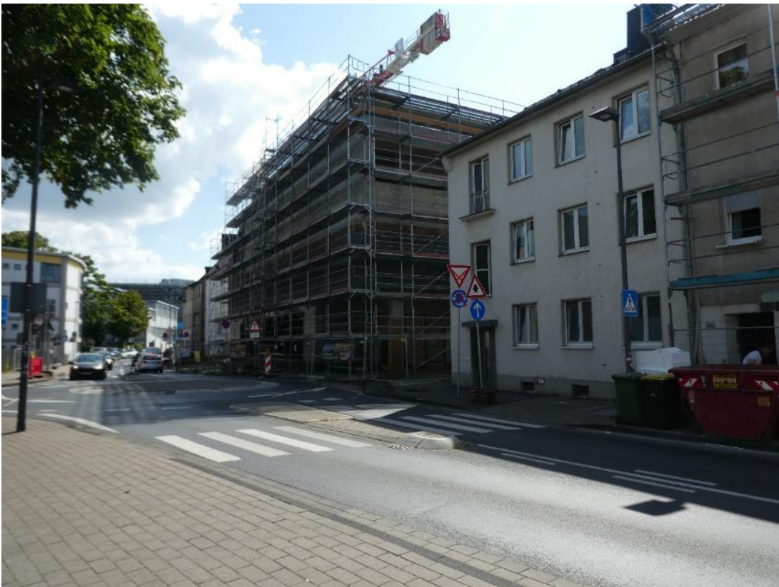
Abbildung 3: Blick Richtung Südwesten auf den Bau der neuen Vierfach-Turnhalle, südlich des Geltungsbereichs des Bebauungsplans an der Wilhelmstraße (25.08.2025).
