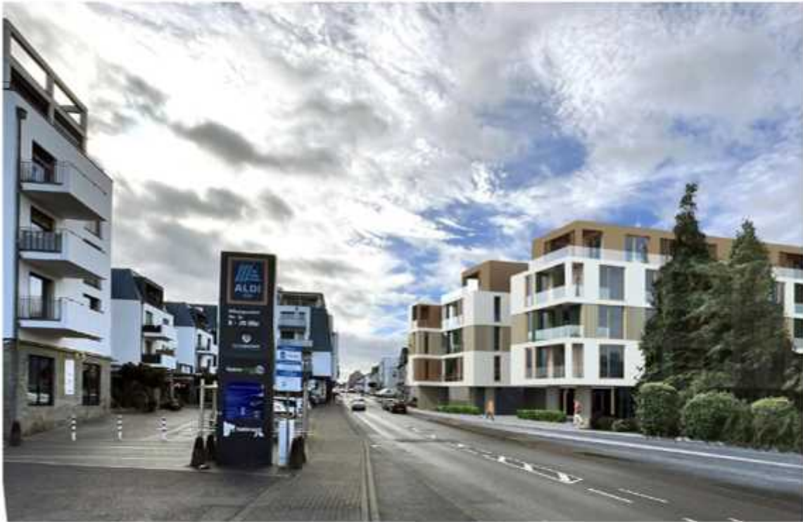
Errichtung einer Wohnanlage mit Gewerbefläche Hauptstraße 56 in Siegburg
