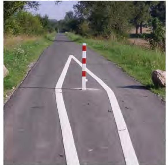
Abbildung 1: Warnmarkierung eines Sperrpfostens
