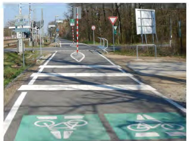
Abbildung 3: Baulicher "Rüttelstreifen" mit taktilem Elementen (Rippenplatten) zur Aufmerksamkeitssteigerung
