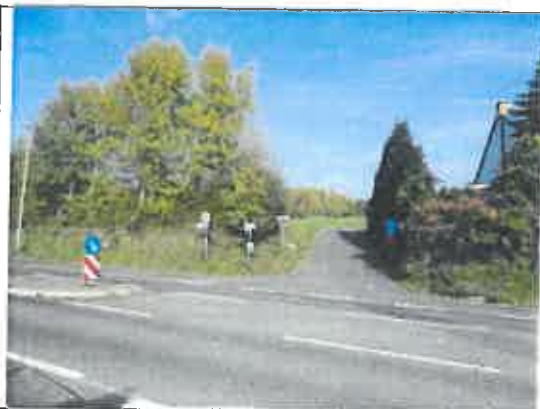
Foto 2: Anschlusspunkt Zufahrtsweg an die Idsteiner Straße
