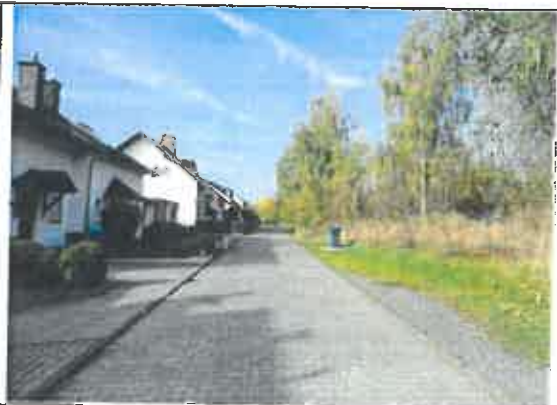
Foto 3: Privatweg, Erschließung der Wohngebäude Idsteiner Straße Nr. 74 – 92
