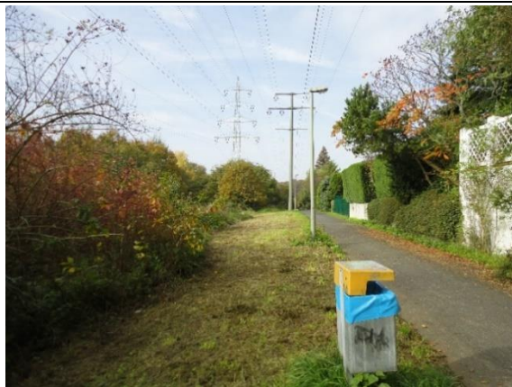
Foto 14: Stromtrasse im Norden des Plangebietes
