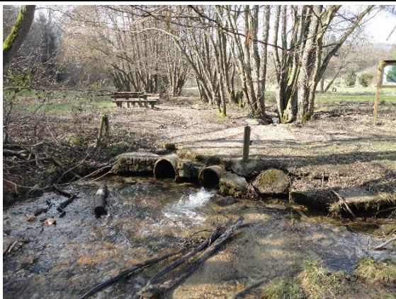
Foto 15. Bachverrohrung Flurstück 21, Flur 22
