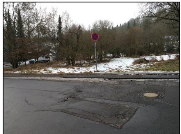
Eschenhahner Weg in Blickrichtung Südwesten
