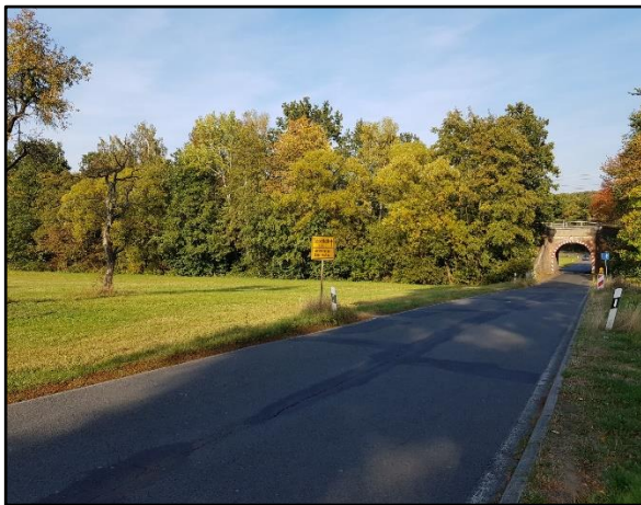
Blickrichtung Osten (Viadukt)
