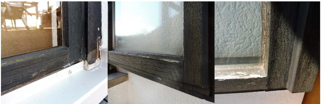
1. Massive, witterungsbedingte Schäden an Holzfenstern, hohe Wärmeverluste, Zugluft in den Büros, starke Aufheizung im Sommer
