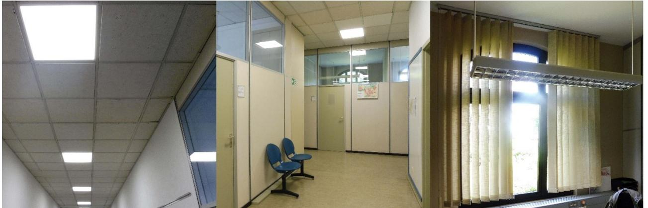
3. Trennwände schadstoffbelastet mit einem unzureichenden Schallschutzanforderungen, altersbedingte Abnutzung von Oberflächen
