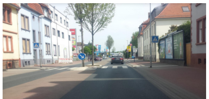
Beispiel 2: Multifunktionsstreifen (Abbiegestreifen, Querungshilfe) mit verkehrsberuhigenden Elementen auf der Friedberger Straße in Bad Vilbel
