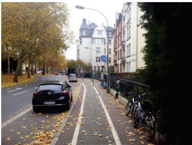
Sehr schmaler Benutzungspflichtiger getrennter Geh- und Radweg mit unzureichender Platz für den Fußverkehr - Frankfurt am Main
