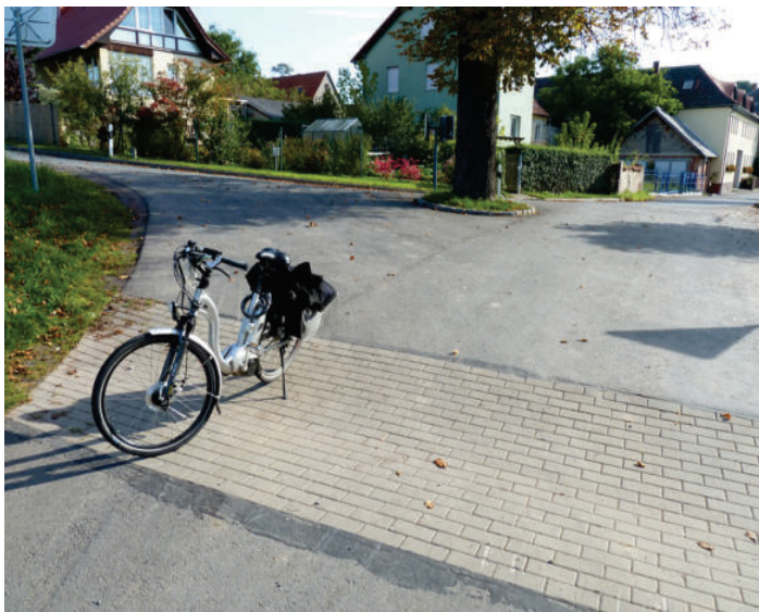
Großzügige Mulde als Entwässerungsrinne
