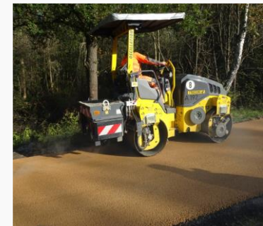
Asphaltähnliche Oberflächen aus Basaltstein und Spezialsanden (Quelle: BioSi Balastan®, Schweizer Ideen-Werkstatt) / Heller Split-Mastix-Asphalt
