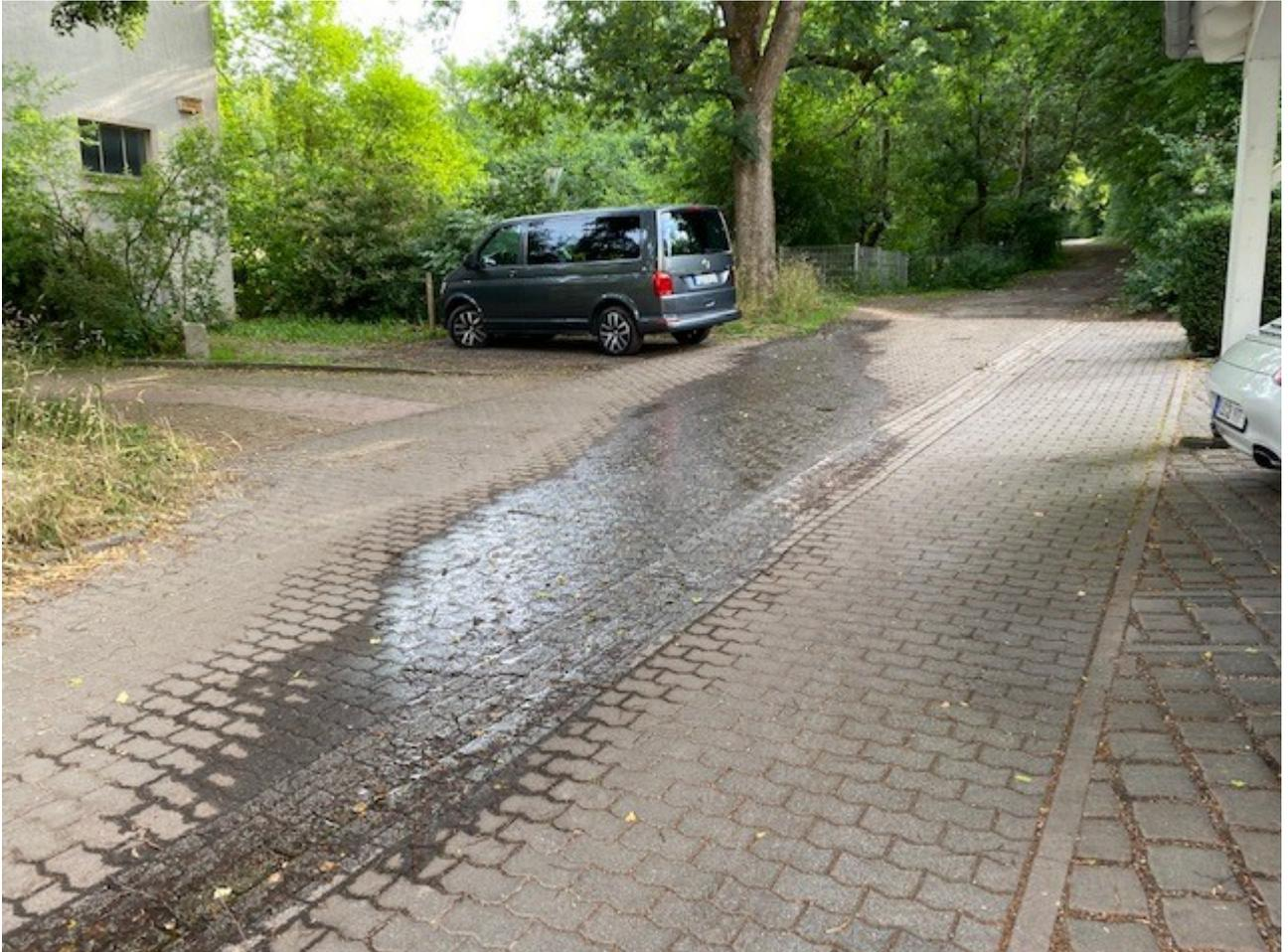
Damit zukünftig kein Grund- bzw. Bachwasser mehr oberflächlich abfließt, wurde die Firma Jacobi beauftragt, einen zusätzlichen Sinkkasten in Höhe des Einlaufbauwerks, am äußeren Rand der Pflasterfläche, einzubauen. Ziel es, das Wasser zu sammeln und abzuleiten, bevor es die Straßenoberfläche erreicht.
