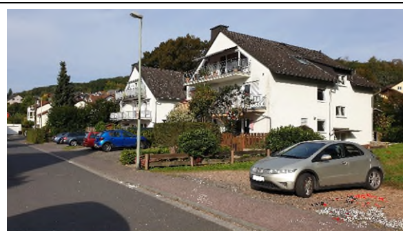
Foto 2: Bebauung im Langgraben 2-geschossig mit Satteldach
