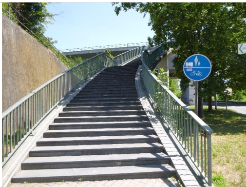
Bsp. Hindernis: Treppe als Teil einer Radverbindung
