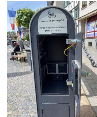
Ladestation für den Radverkehr mit Schließfach und externer Lademöglichkeit
