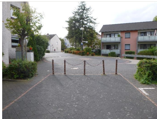
Bsp. Gefahrenstelle: unmarkierte, eng gestellte Sperrpfosten mit Kette auf Radverbindung
