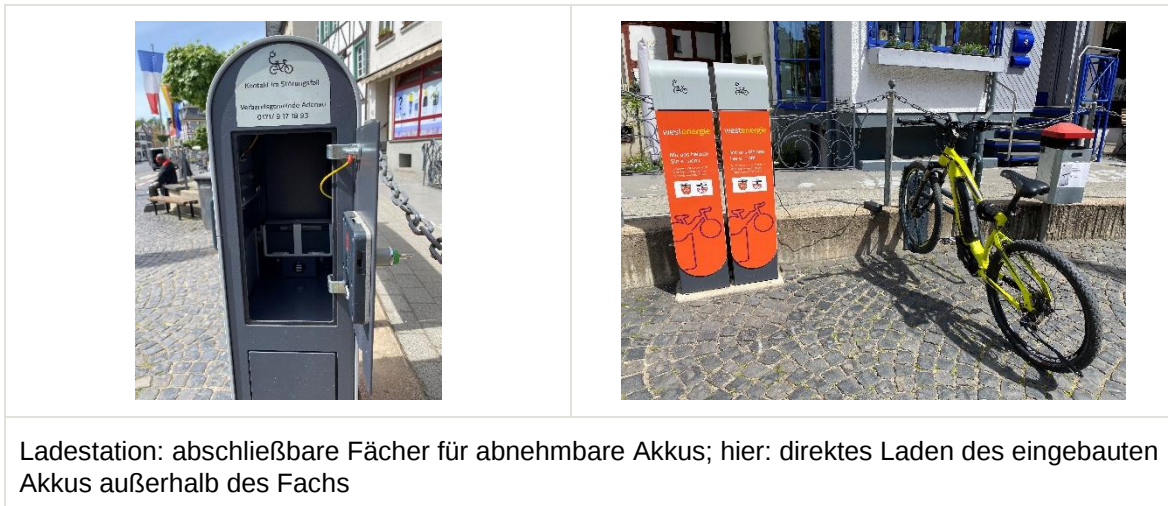
Abbildung 23: Beispiel für Ladestation
